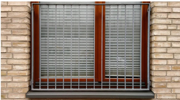
STAKETENGELÄNDER VOR DEN FENSTERN
