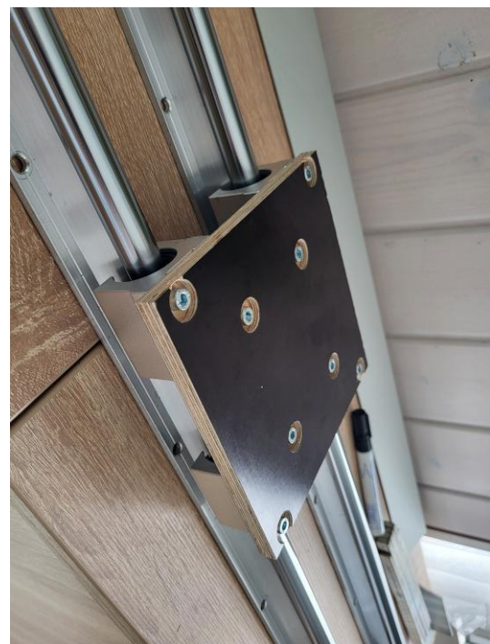
Abbildung 101: Montage Gleitschienen
